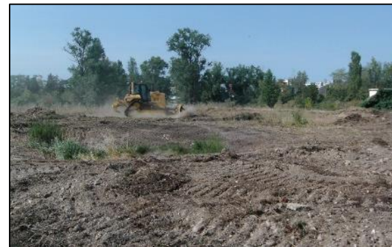
Préparation du terrain : nivellement, décompactage...
