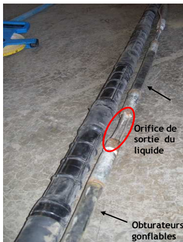
Mise en œuvre de l'injection par tubes à manchettes
