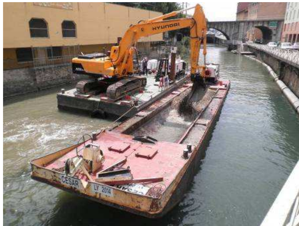
Pelle sur ponton et restitution par clapage
