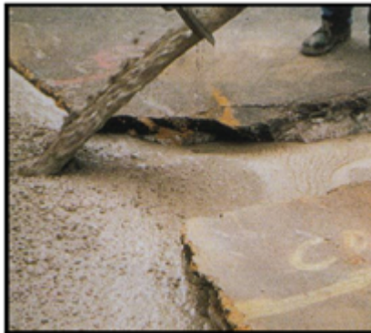
Remplissage de tranchée avec un remblai autocompactant. (Source : thèse de [P-Y. SCORDIA, 2008])
