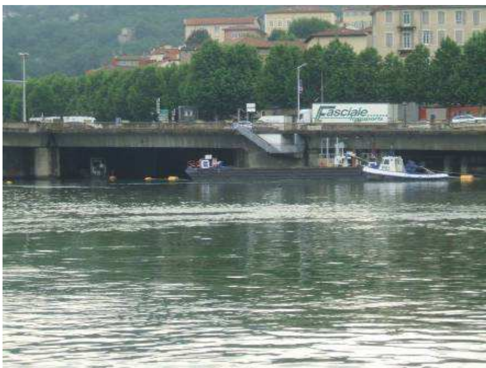
Drague aspiratrice sous tunnel et restitution au Rhône par clapage
