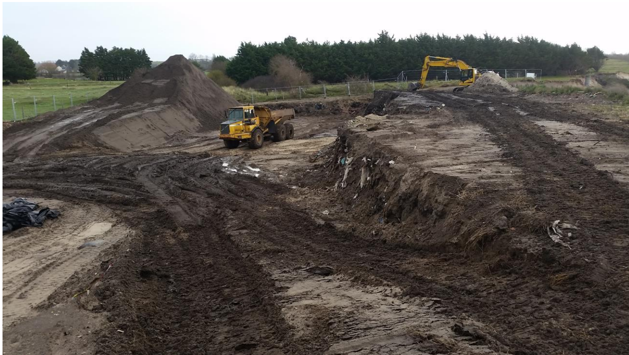
Photo de l'extraction des déchets avant transport vers la plateforme de criblage.
