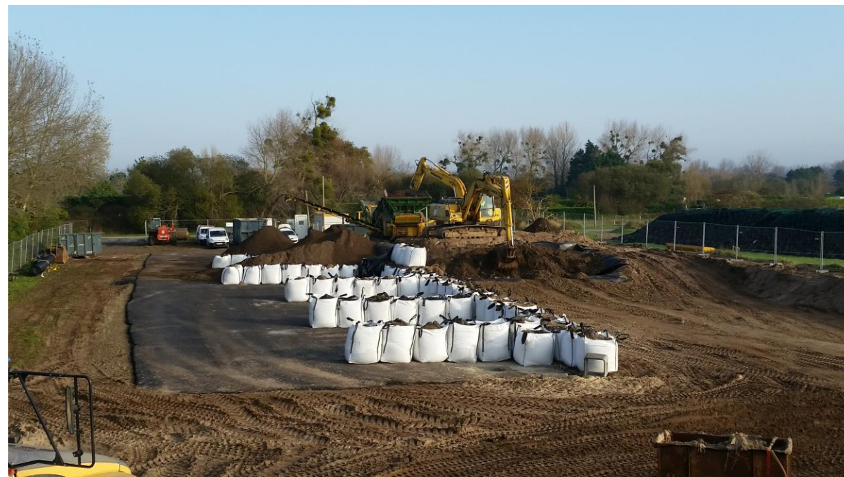
Photo de la plateforme de criblage adjacente au site. La partie goudronnée sur rétention sert d'entreposage des fines en attente des retours d'analyses.
