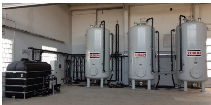
Station d'épuration des eaux souterraines PFAS, Vallée du Rhin
