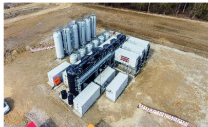
Ancienne raffinerie, barrière hydraulique (Ingolstadt), 210 m³/h
