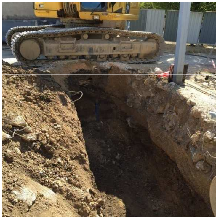
1 – Terrassement de la tranchée extérieure sur 1,5 m de profondeur
