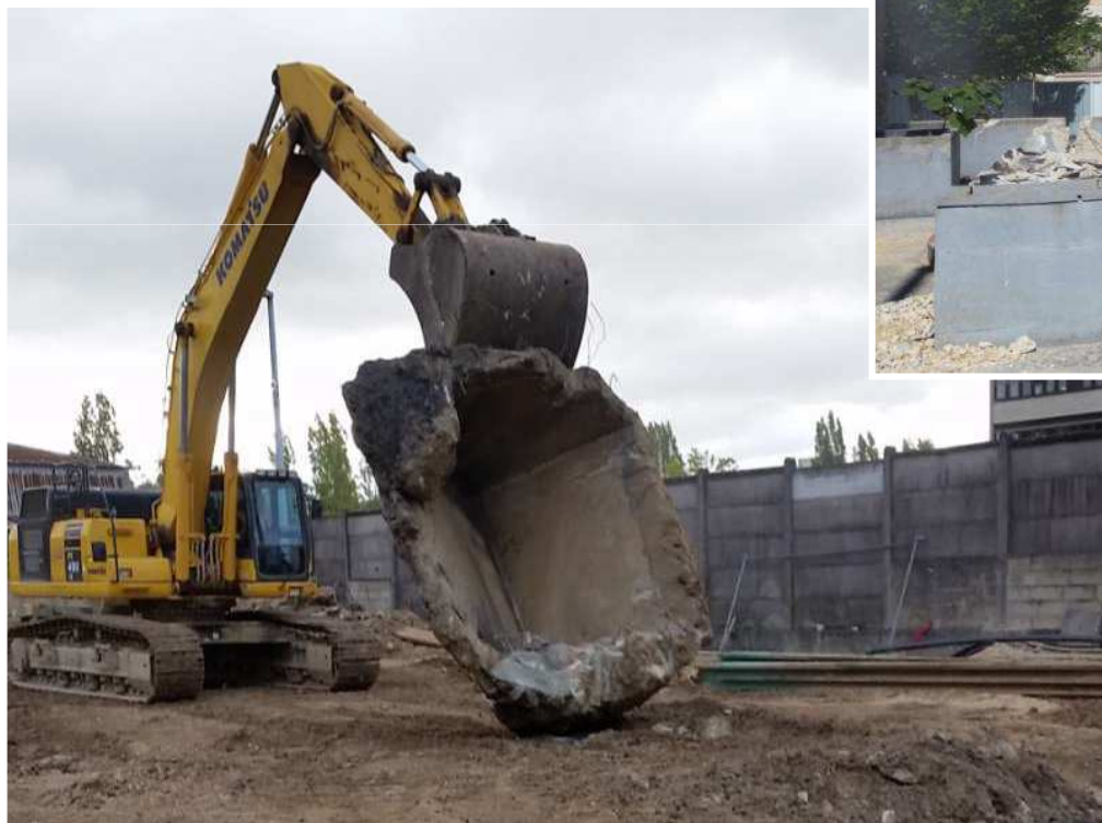
Démolition du béton de surface et extraction des ouvrages enterrés
