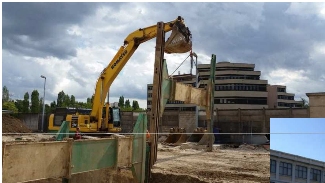
5 – Mise en place du traineau intérieur pour maintien des panneaux latéraux
