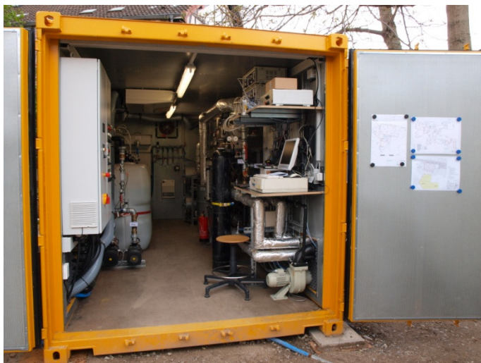
Container dédié à l'aspiration des gaz et au monitoring
