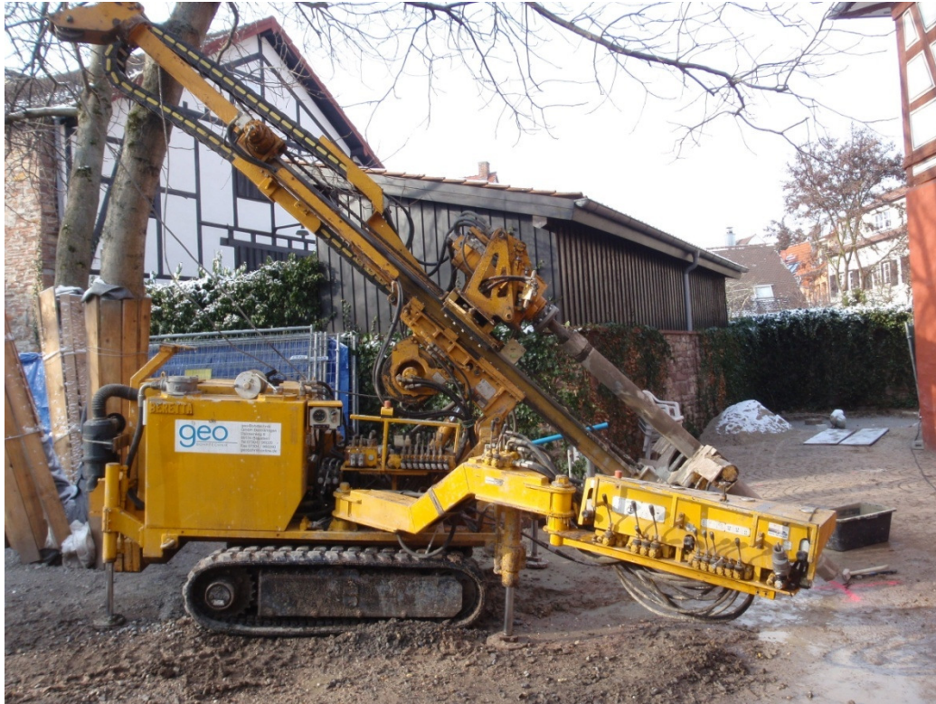
Mise en place des puits inclinés sous le bâtiment
