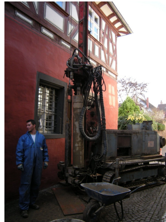
Mise en place des forages verticaux
