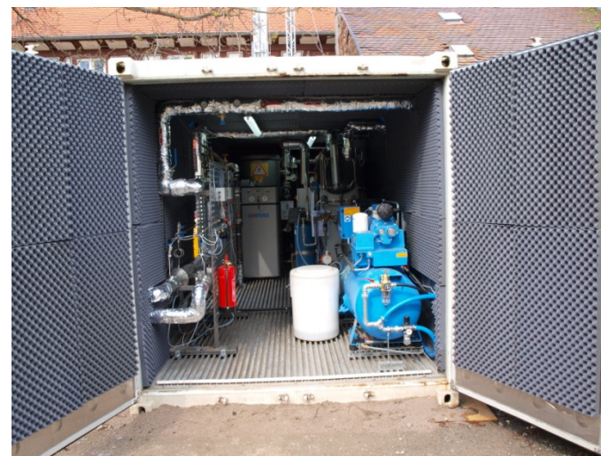
Container dédié à l'injection de vapeur
