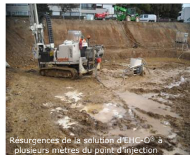
Eau souterraine irisée et solution blanchâtre d'EHC-O® refoulées du sous-sol
