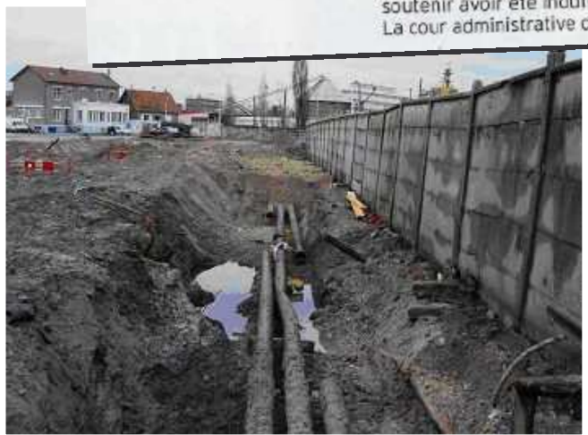
Rupture Franche d'une tuyauterie d'hydrocarbure dans une zone industrielle lors de travaux de réaménagement
