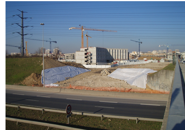
Recouvrement des talus pour limiter la mobilité des polluants en phase chantier
