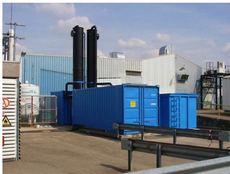
Fig. 4 : Unité compacte de dépollution de nappe phréatique
