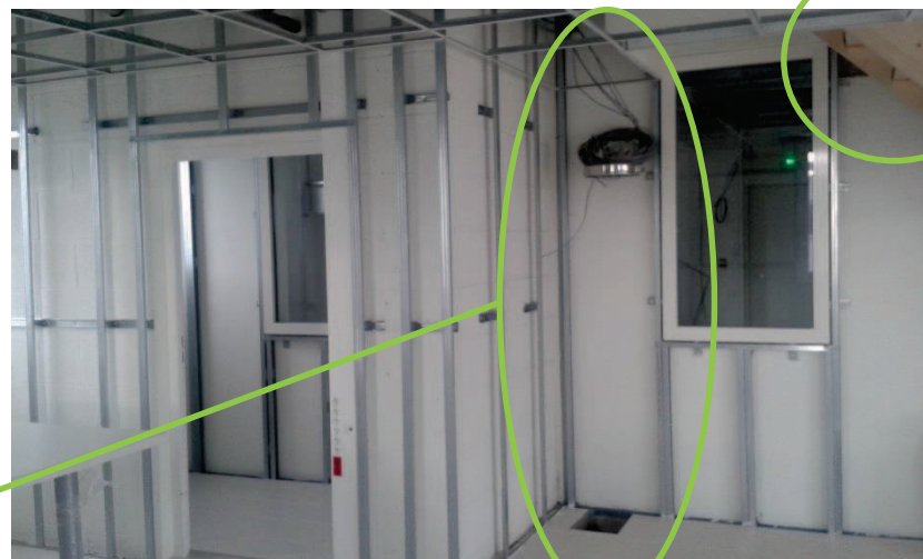
Réservation pour conduit de cheminée, foyer ouvert, fermé et poêles...
