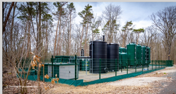
Fig. 2: Installation de traitement des eaux souterraines PFAS, Qw = 125-150 m³/h, sécurité hydraulique en aval avec zone de captage de l'usine d'eau, Berlin
