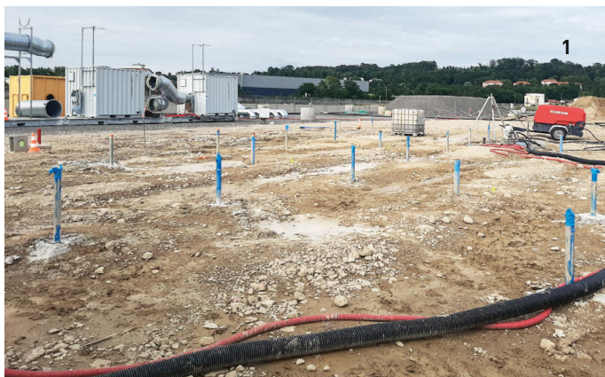
1 Zone d'injection ISCO avec tubes à manchettes, 2 France, / 2 Station de dosage permanganate / 3 Injection de persulfate, Allemagne de Sud
