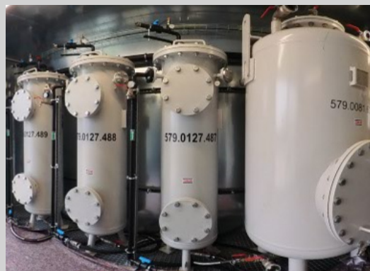
Fig. 4: Combinaison de procédés d'adsorption sur charbon actif / échange d'ions. Installation de purification d'eau Qw = 7,2 m³/h, Site militaire américain, Allemagne
