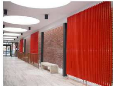
Photo 32 : La peinture plombée de ces radiateurs est actuellement inaccessible
