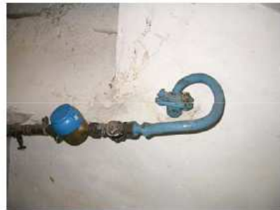
Photo 24 : Adduction en plomb (avant le compteur)
