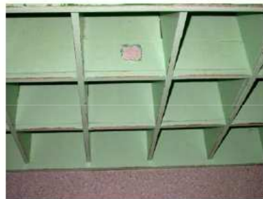
Photo 28 : Peinture accessible, elle s'écaille et de traces d'usure sont visibles
