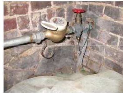
Photo 25 : Adduction en plomb (avant le compteur)
