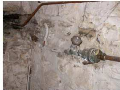
Photo 26 : Adduction en plomb (avant le compteur)
