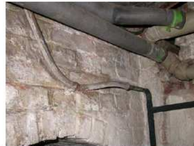
Photo 27 : Tuyauterie intérieure en plomb (après le compteur)
