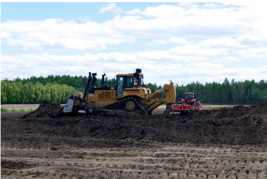
Activité de défrichage de foncier agricole : excavation de terres pour reprofilage et potentiel utilisation en terres végétales
